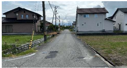
④途中から用水路フタがない
